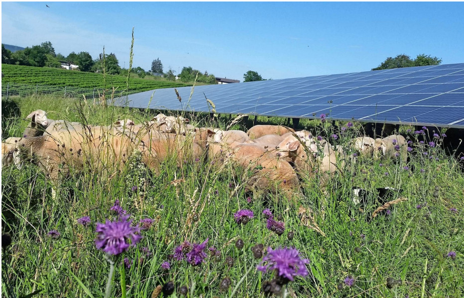
Die Freiflächen-Photovoltaikanlage Schafhaus in Brackenheim ist das Vorzeigeprojekt der Bürgerenergiegenossenschaft Neckar-Zaber. Foto: privat
